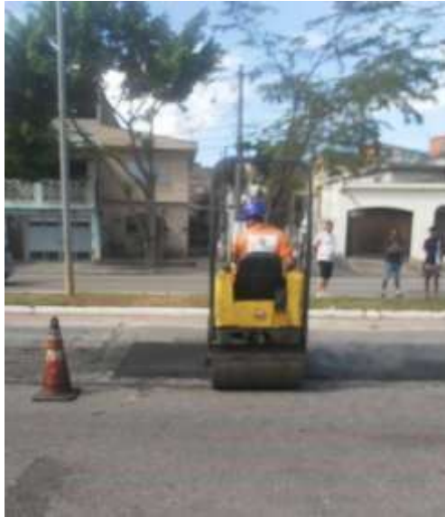
Foto 5 – Operador de rolo compactador finalizando o serviço
