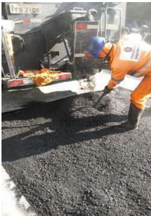
Foto 4 – Funcionário ajudando no espalhamento da massa asfáltica.
