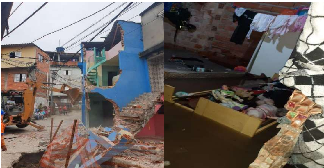
Rompimento de galeria – Rua Califórnia - 15/01/2020; Inundação – Passagem Cristiano Banti – 01/01/2020.
